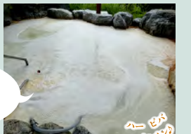
丁寧な作業が必要な 岩風呂のメンテナンス。 写真は化学洗浄の様子
